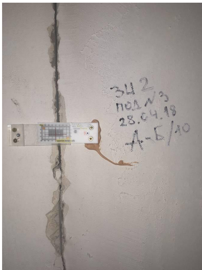
Маяк ЗИ2 техэтажа подъезд 3 (секция 1).
