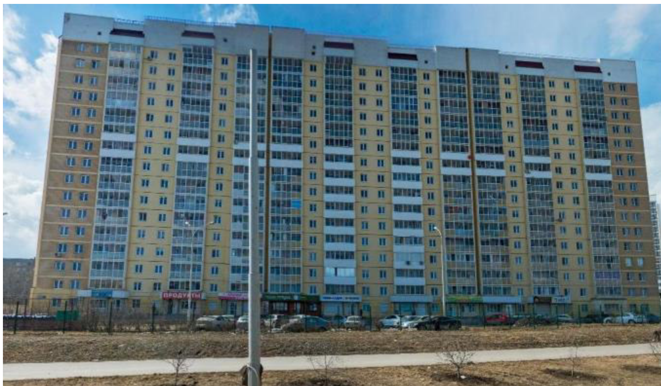
Общий вид здания многоквартирного жилого дома № 79 по ул. Таганская.
