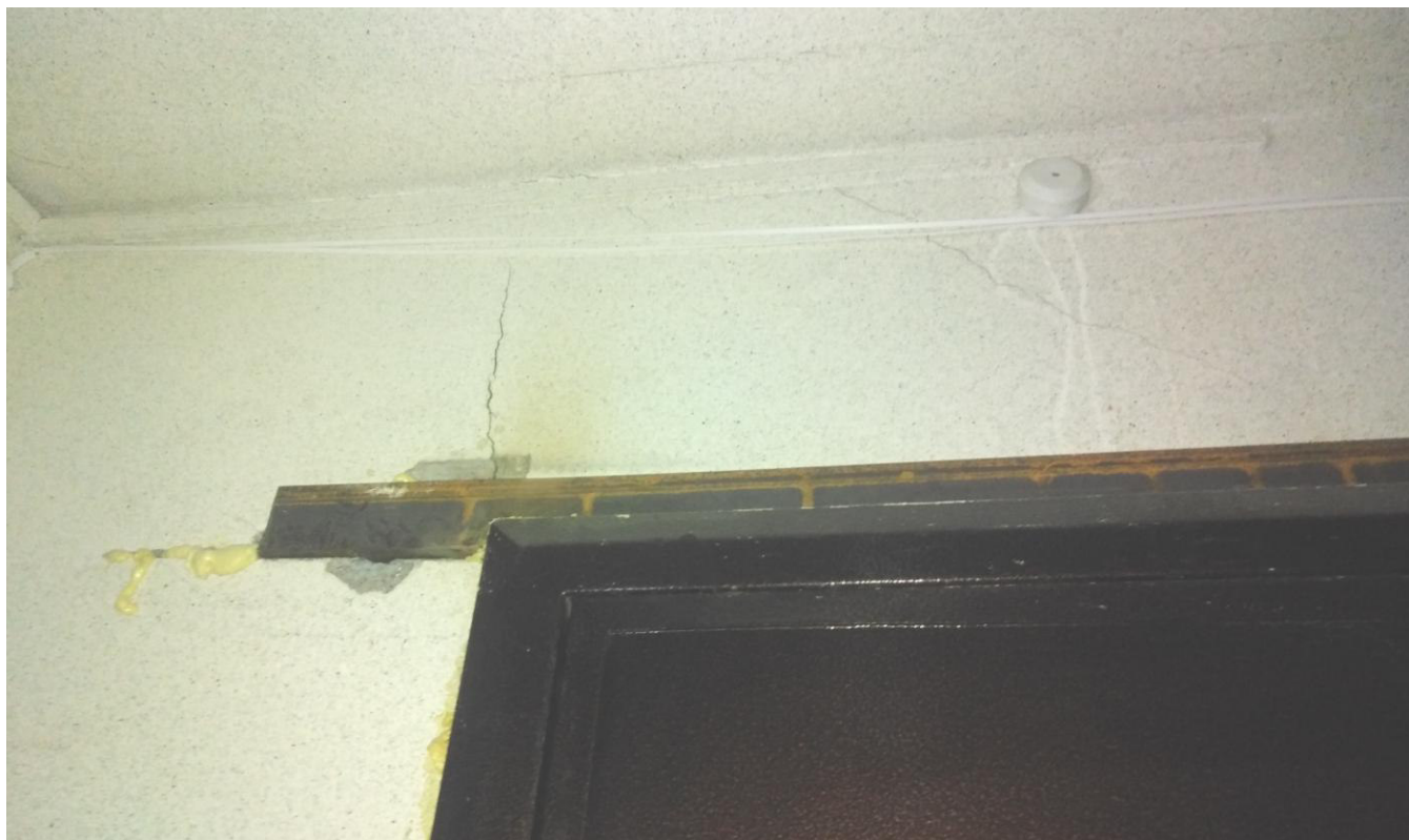
Выполнение металлической перемычки над дверным проемом во избежание повторного повреждения дверной коробки.
