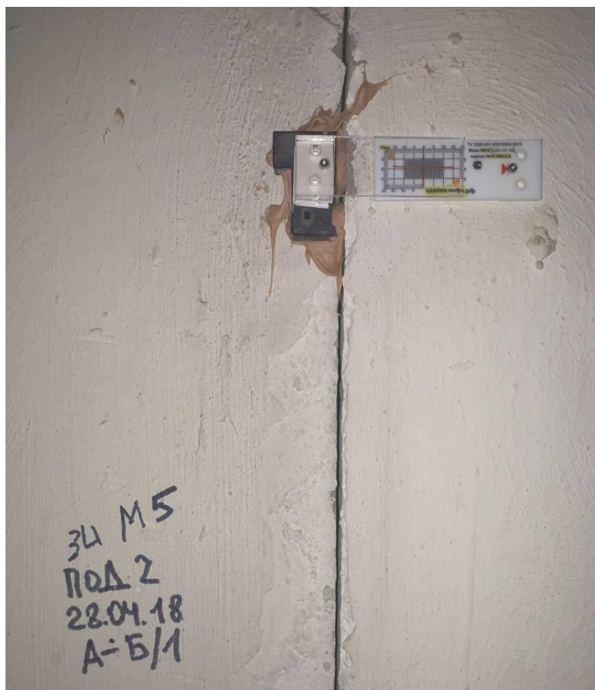
Маяк ЗИ5 техэтажа подъезд 2 (секция 2).
