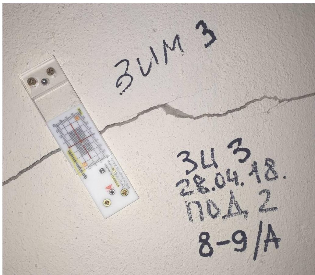
Маяк 3ИЗ техэтажа подъезд 2 (секция 2).
