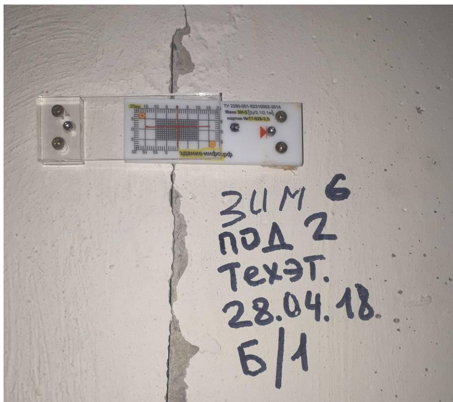
Маяк ЗИ6 техэтажа подъезд 2 (секция 2).
